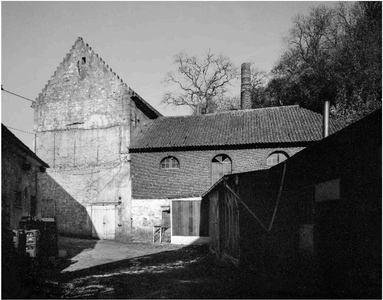
Élévation sur cour de l'atelier de fabrication.
