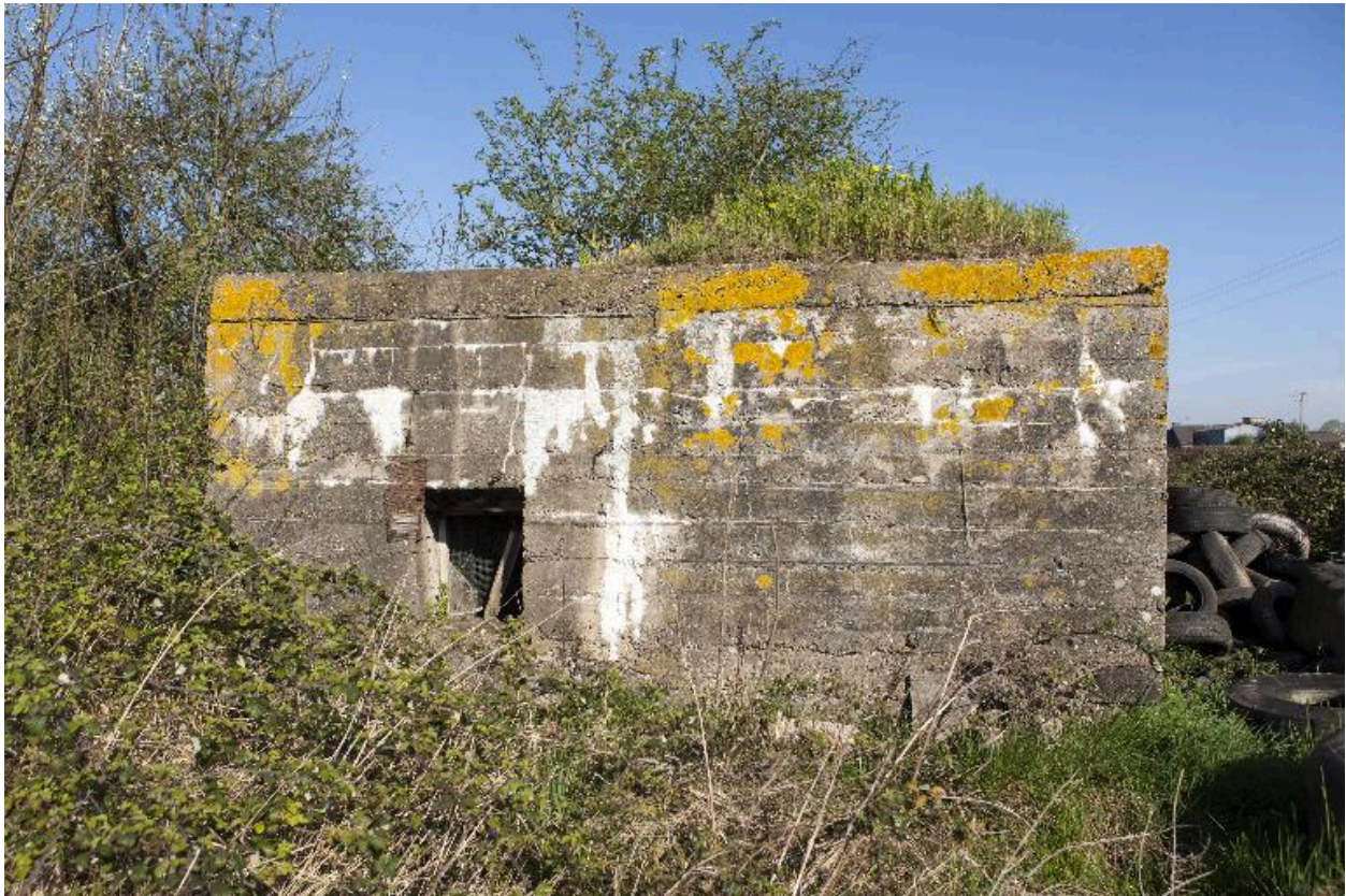
Casemate B, fenêtre sur l'élévation sud
