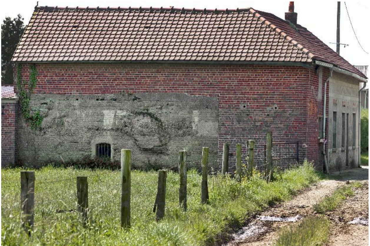
Elévation nord de l'édifice intégré dans un corps de ferme
