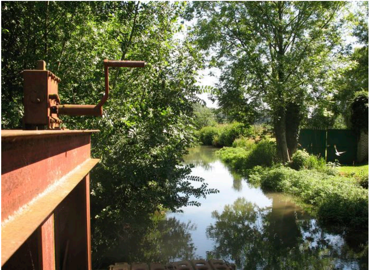
Dérivation de la Nièvre avec au premier plan la crémaillère du vannage de décharge.
