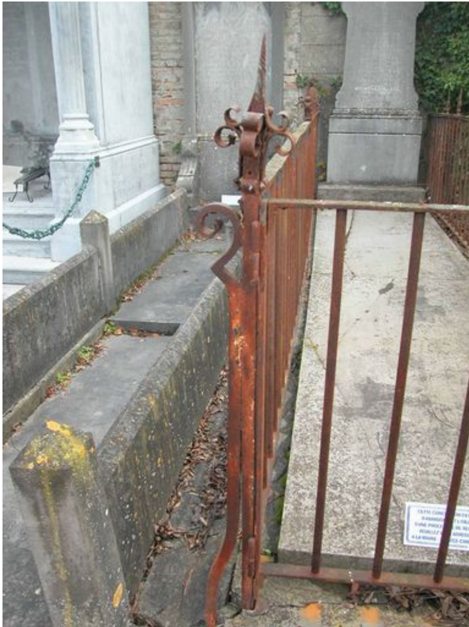
Détail de la grille.
