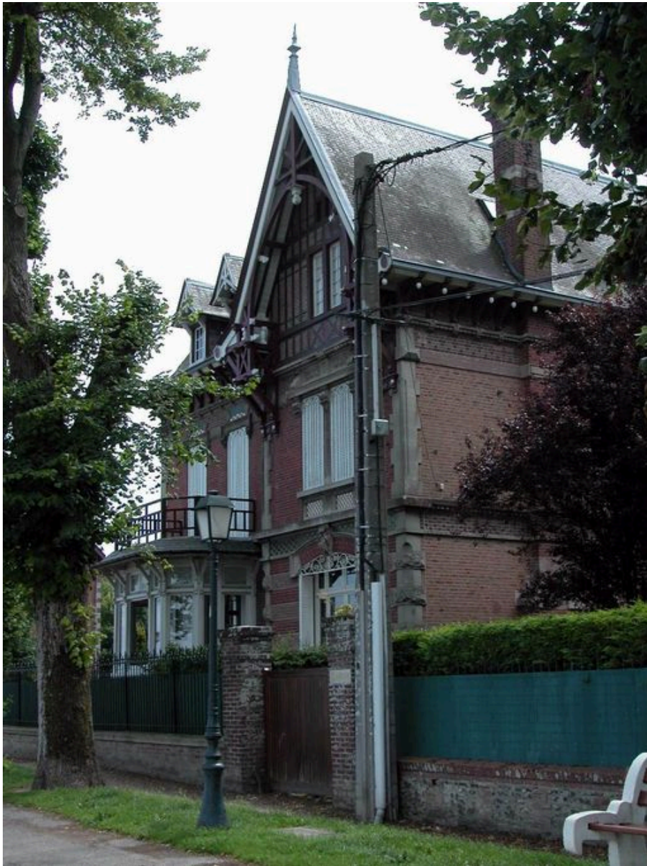
Vue d'ensemble, façade antérieure.
