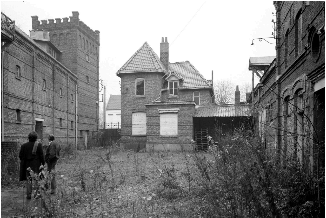
Vue de la cour prise vers le nord-est : à gauche le germoir et la touraille de la malterie, à droite les écuries.
