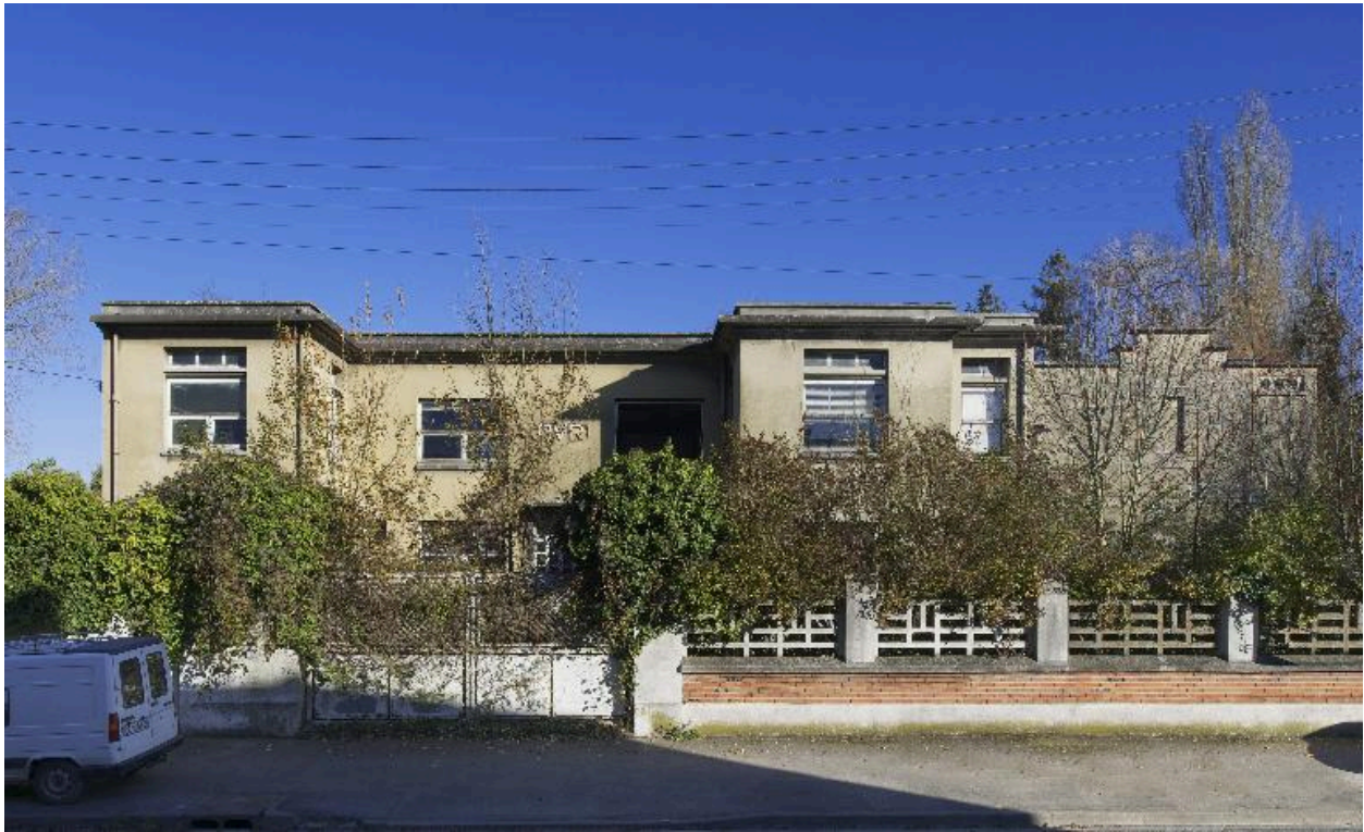
Façade sur rue (ouest) des bureaux.
