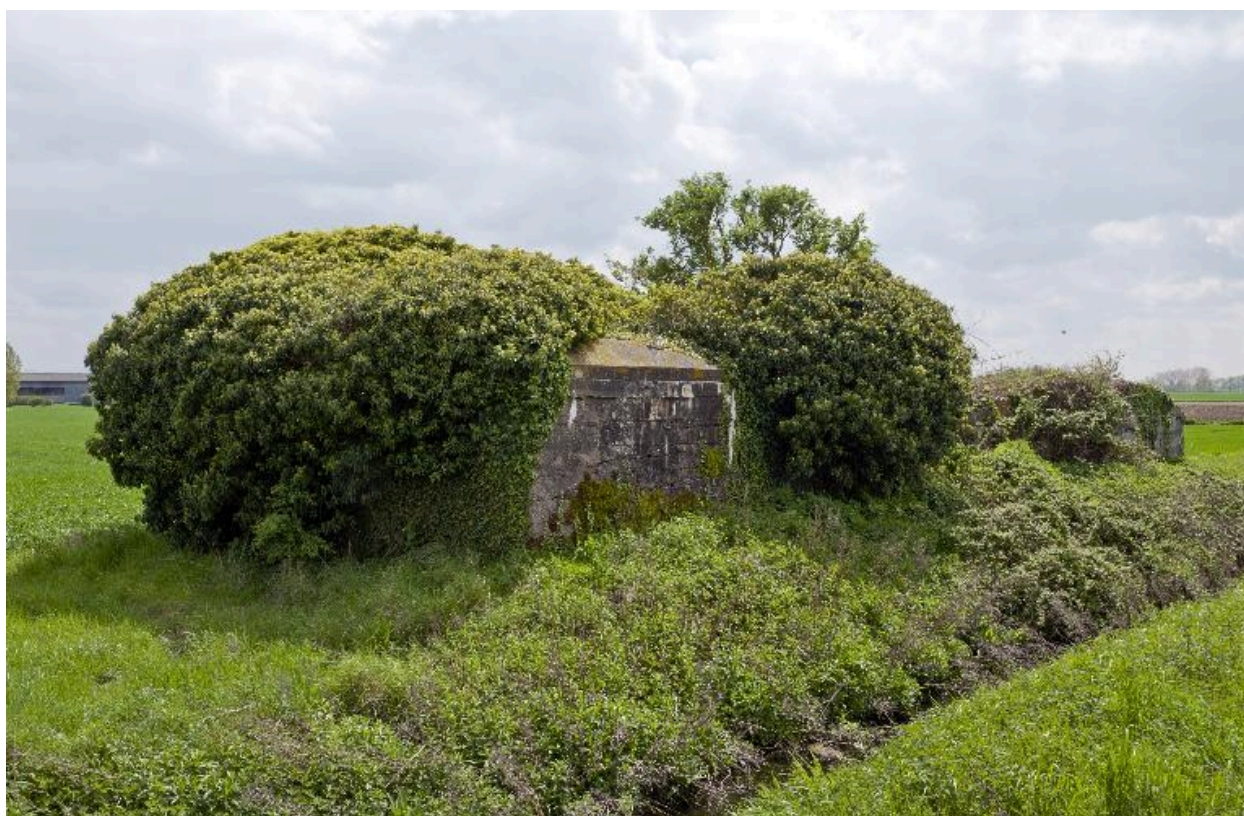
Le bâtiment B, vers le sud, le long du ruisseau
