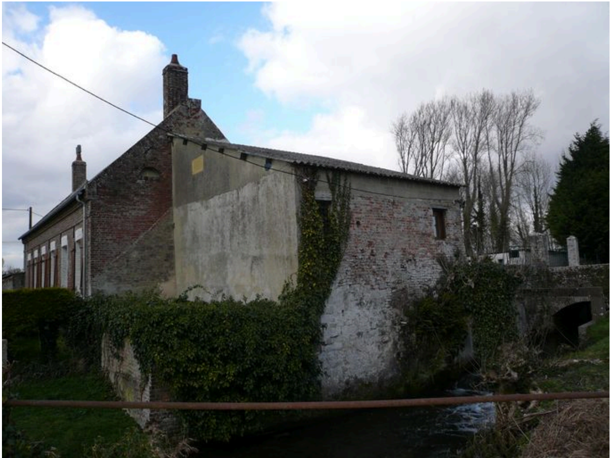
Vue du logis et de ce qu'il reste du moulin à eau.
