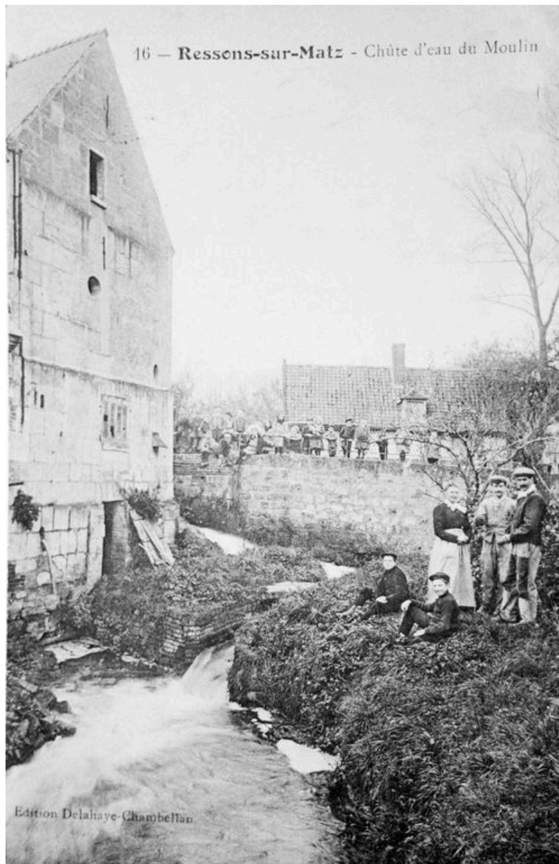
Vue du moulin sur le Matz, partiellement détruit en 1918 (AP).
