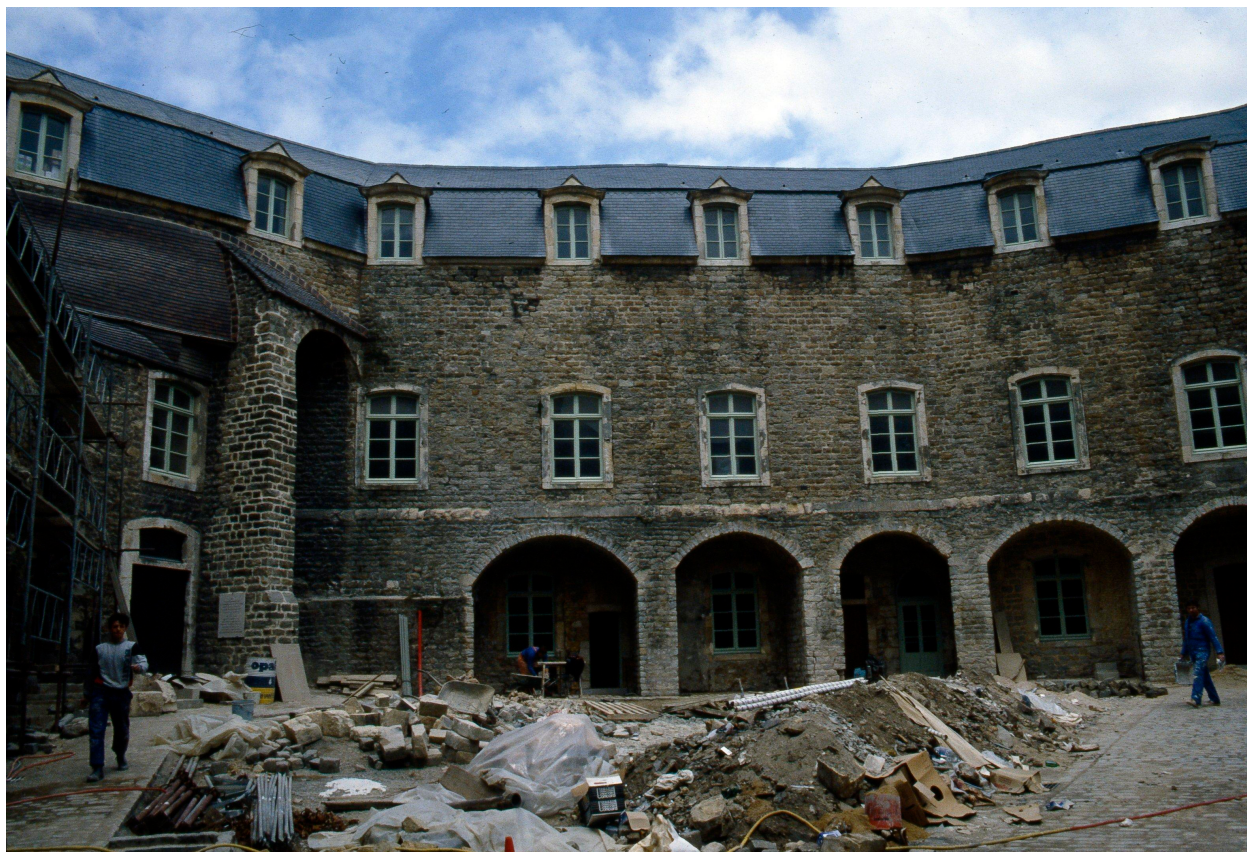
Sur cour d'honneur, façade ouest en cours de restauration (17 juin 1988).
