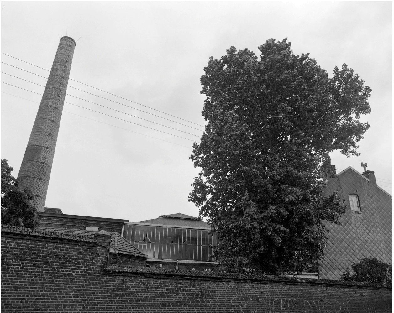
Cheminée, verrière. Vue prise vers l'est depuis la rue Pierre-Brossolette.
