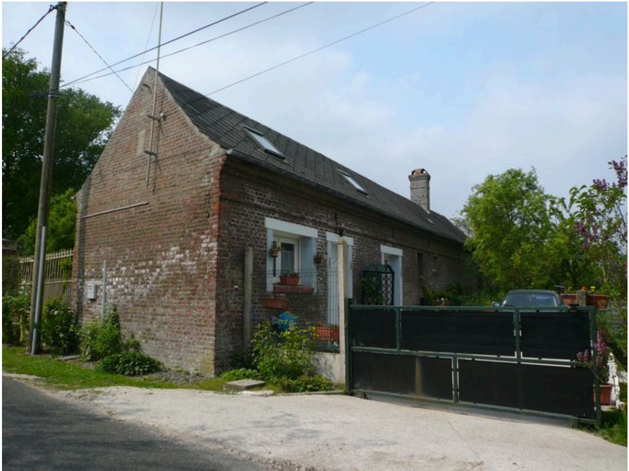
Vue postérieure du bâtiment nord.
