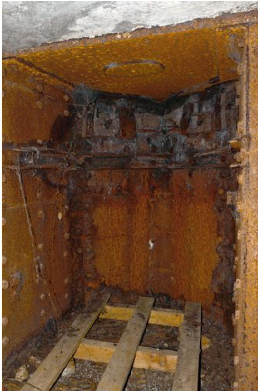
Vue intérieur de l'observatoire cuirassé ouest (au grand angulaire)
