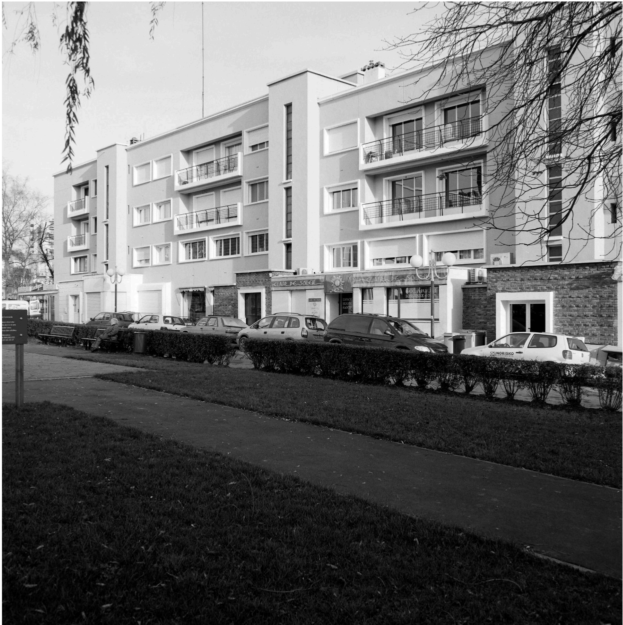
Vue générale de l'élévation postérieure de l'immeuble Les Arcades, construit par l'architecte Jean Badovici.
