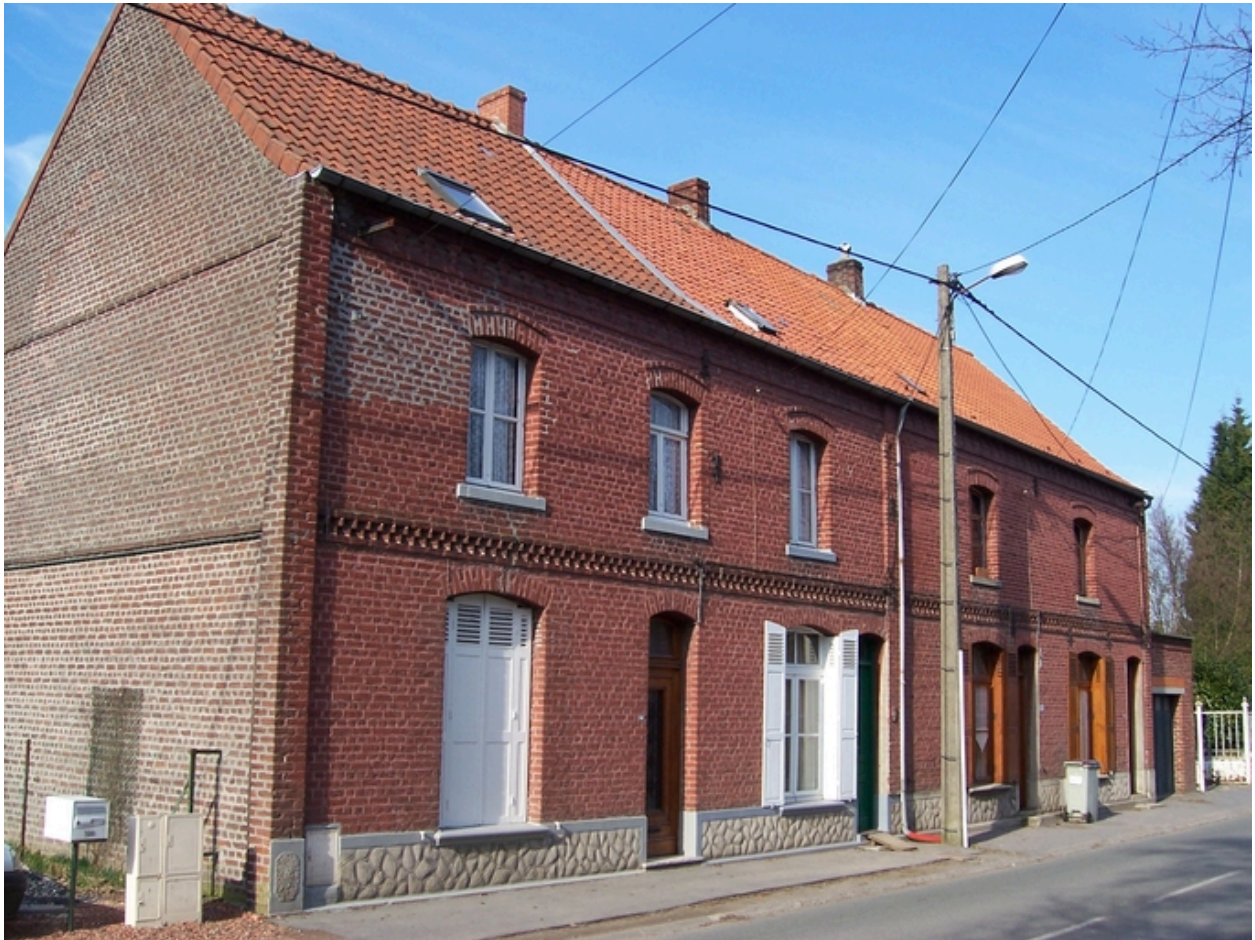
Vue générale de maisons en série, dit coron de la tannerie, rue Varlet.
