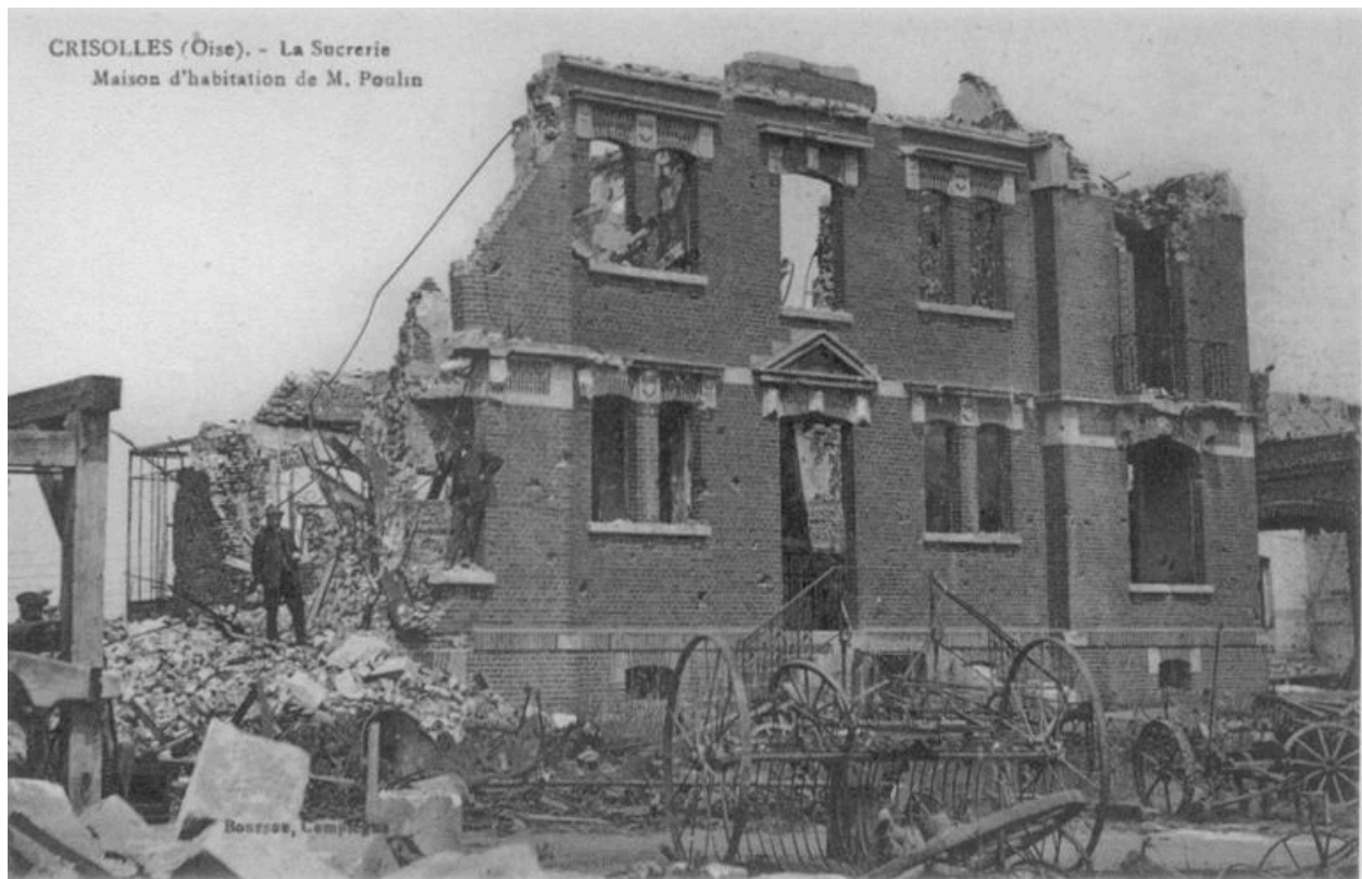
Façade sur cour, après les bombardements de 1918 (AC Crisolles).
