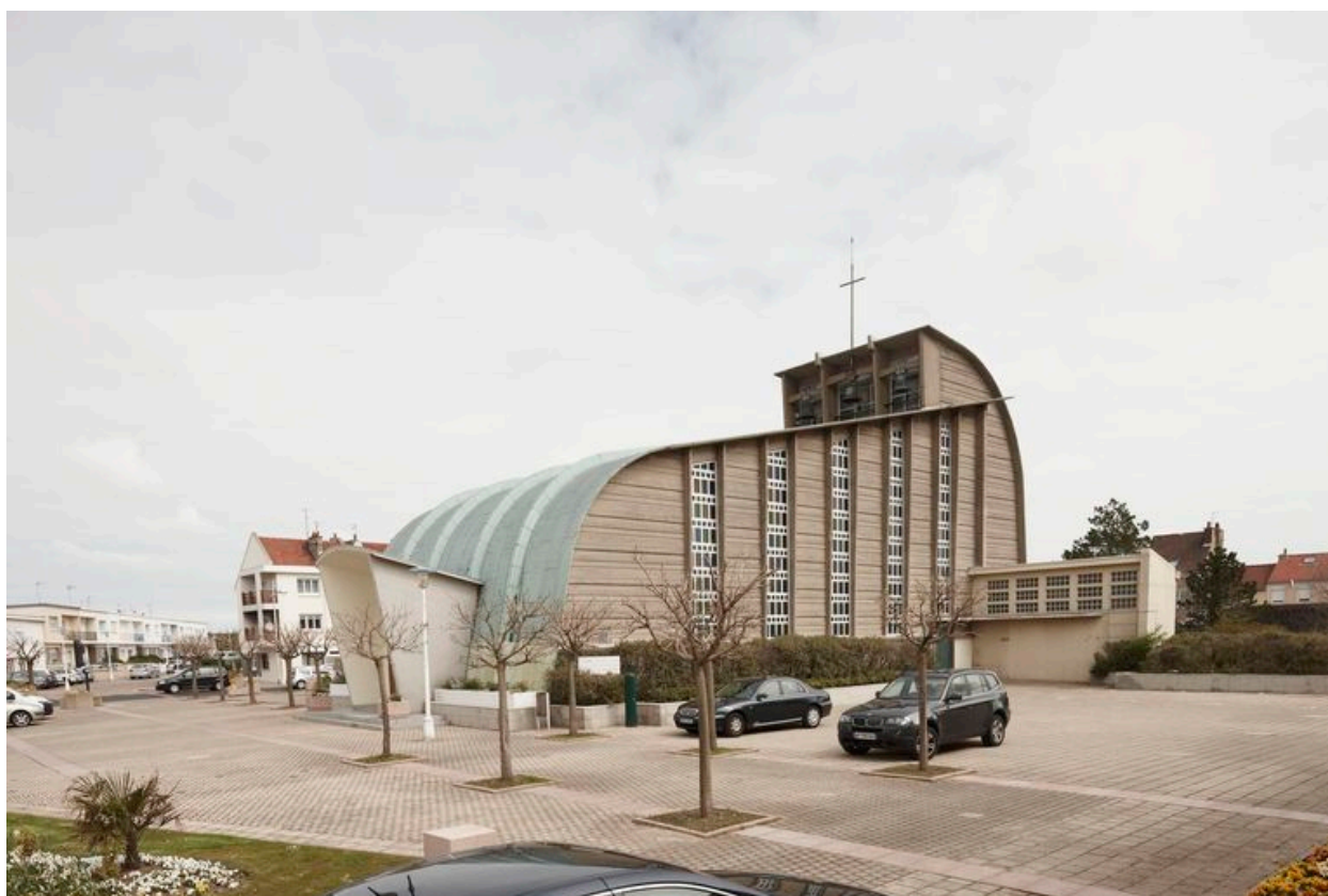
Vue de l'élévation latérale.
