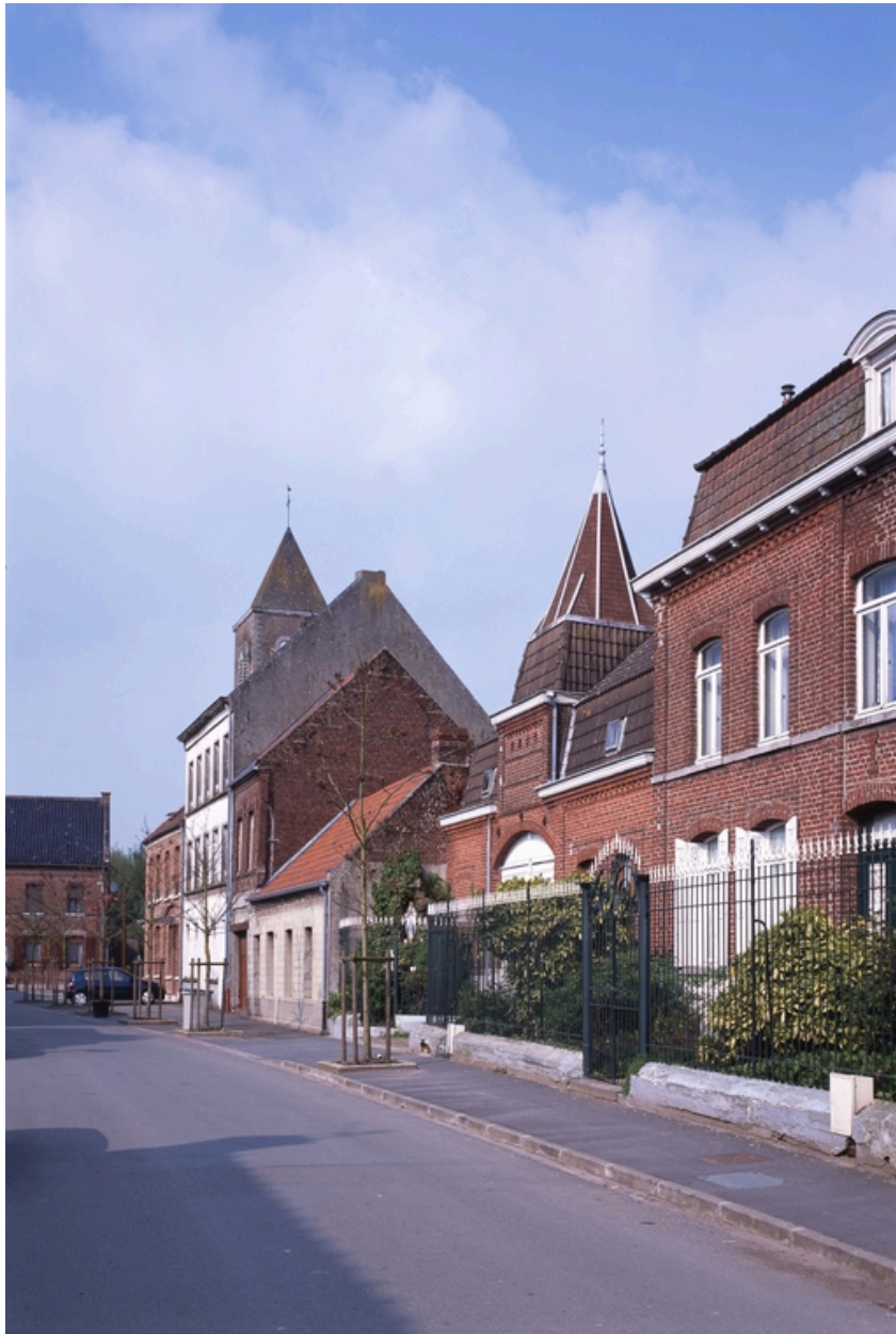
Vue générale de la rue de l'Eglise : ferme (premier plan, n° 51-59), maison à trois niveaux (n° 23).
