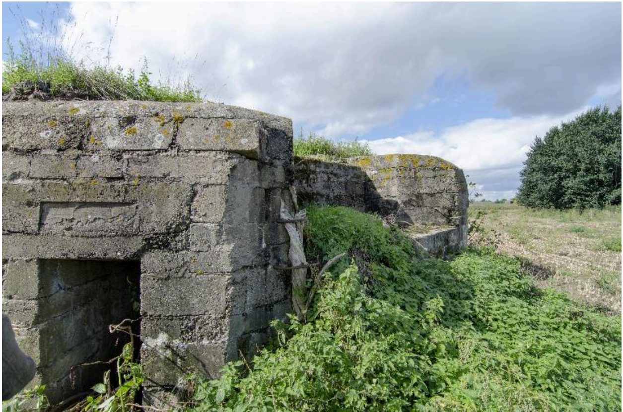
Vue de trois-quarts vers le nord. A gauche, l'entrée sud-est
