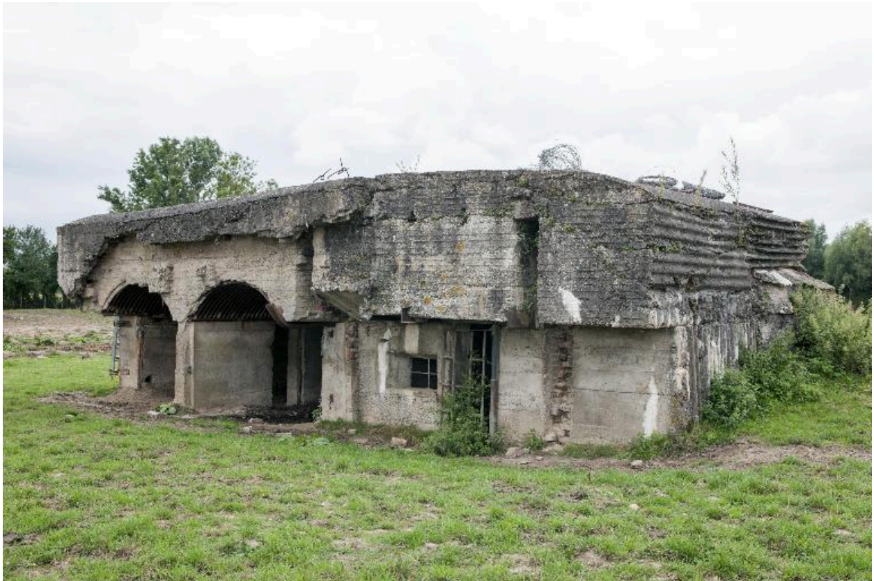
Vue générale vers le sud-ouest
