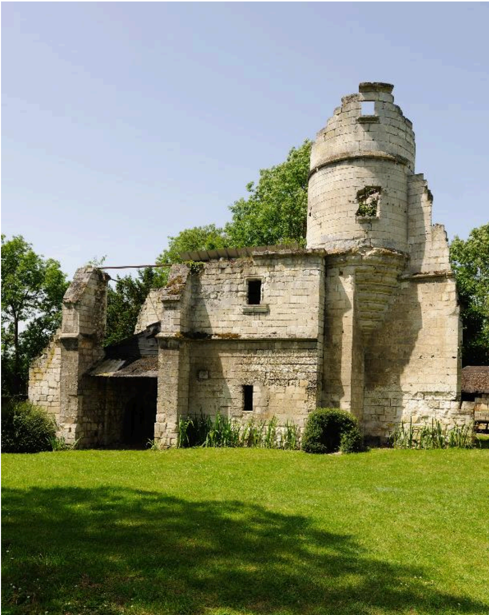
Porterie, vue extérieure depuis l'est.
