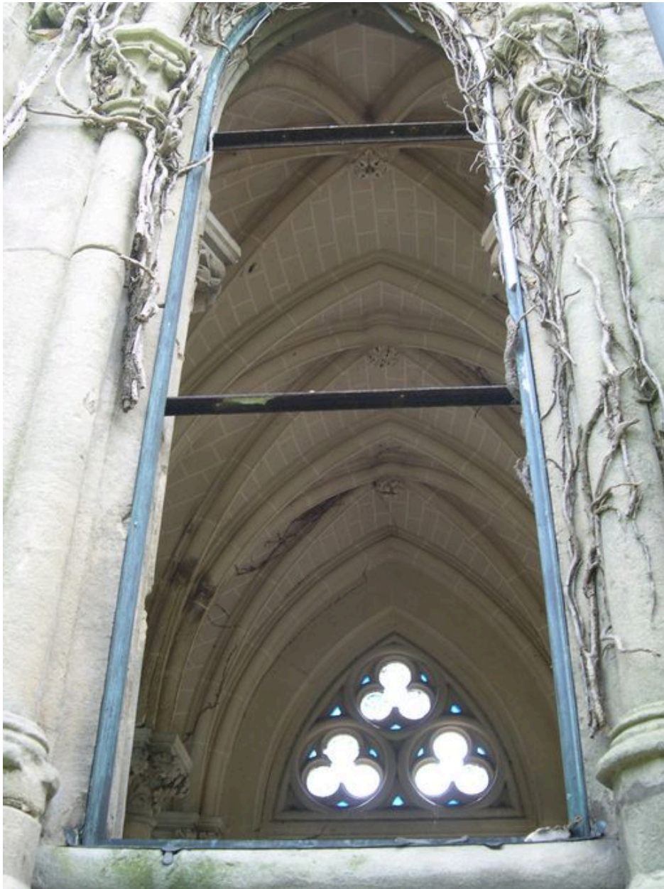
Vue de détail : voûtes.
