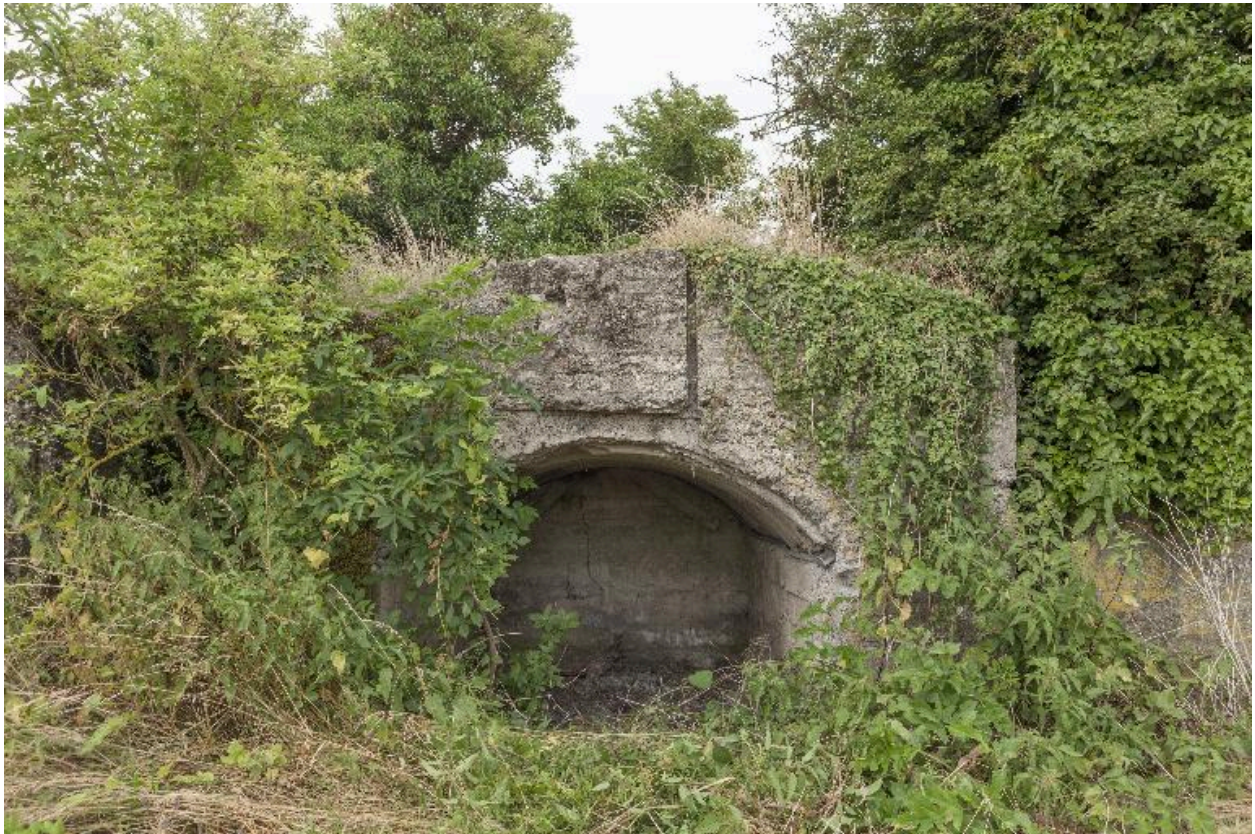
Casemate d, vers l'ouest
