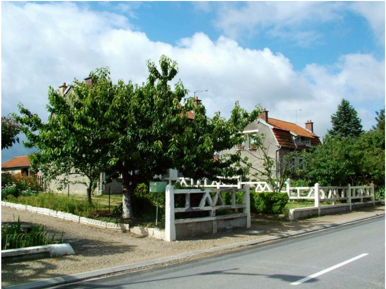
Vue d'une enfilade de maisons ouvrières.
