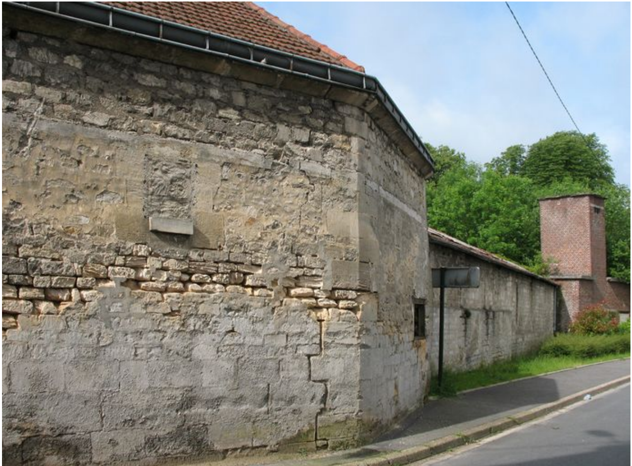
Détail des bâtiments.
