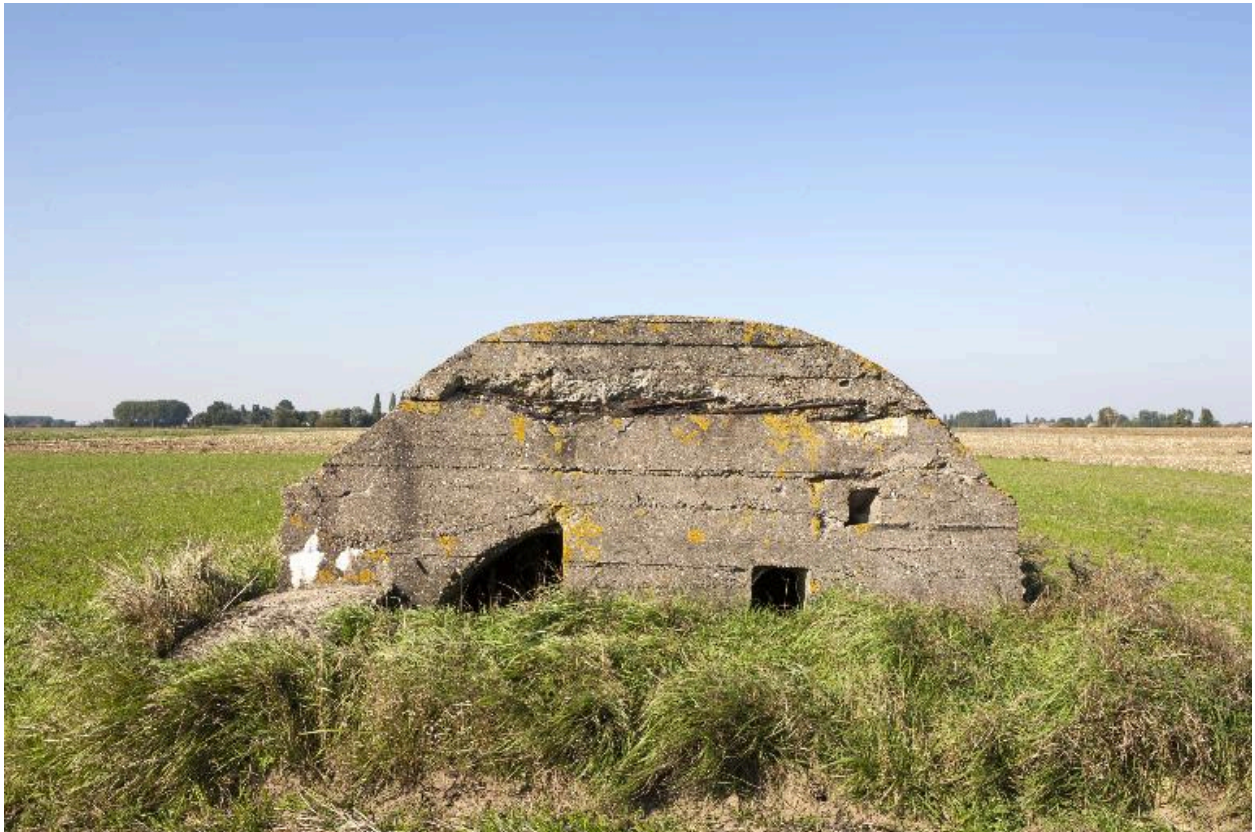
Entrée sur l'élévation sud
