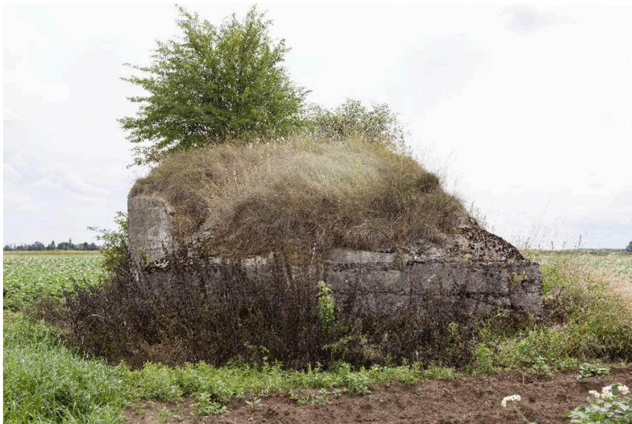
Vue latérale vers le sud
