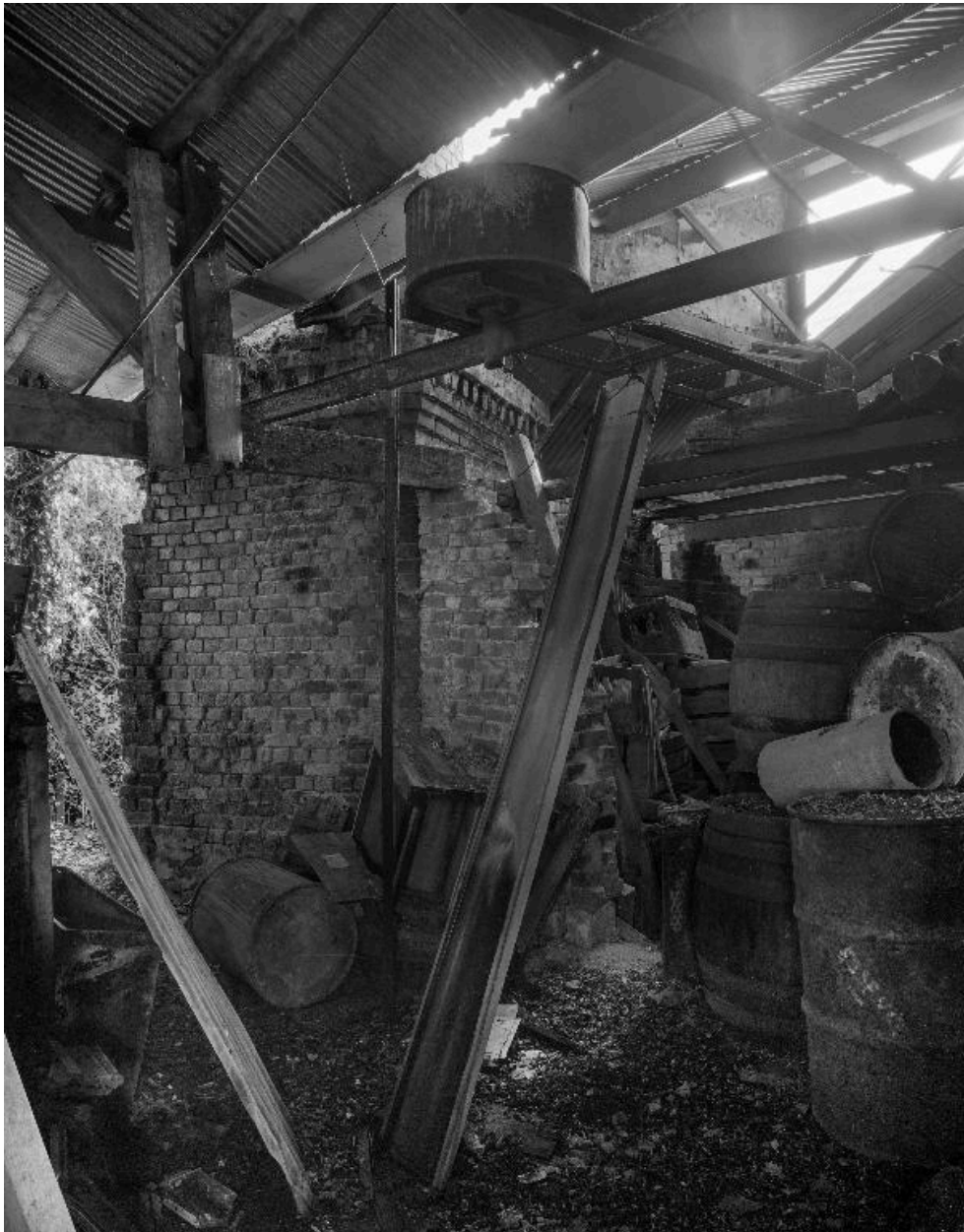
Vue de la base de la cheminée.
