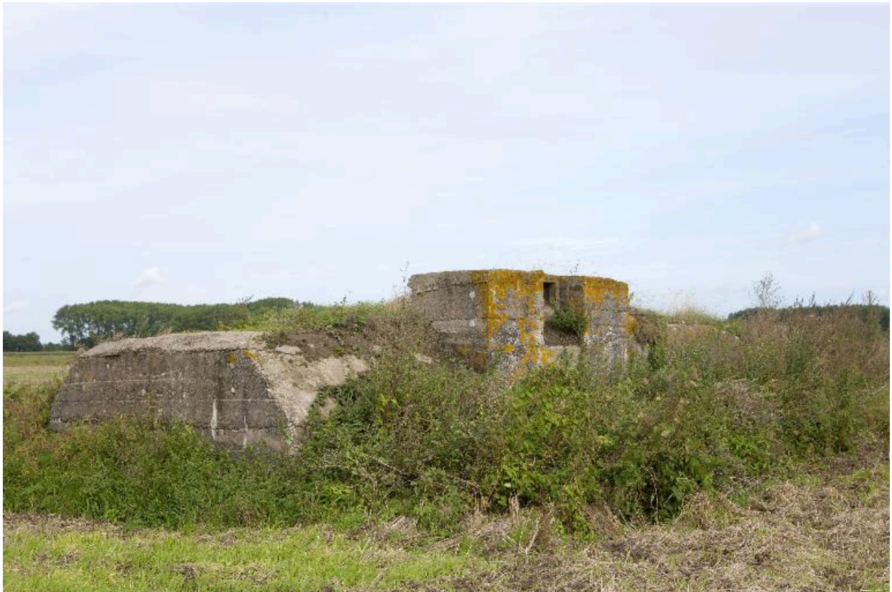
Vue de trois-quarts vers le nord
