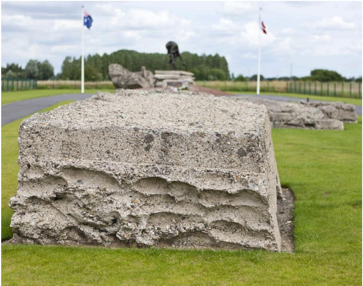
La casemate (a) vers nord-est. Empreintes de sacs de sable ayant servi au coffrage.
