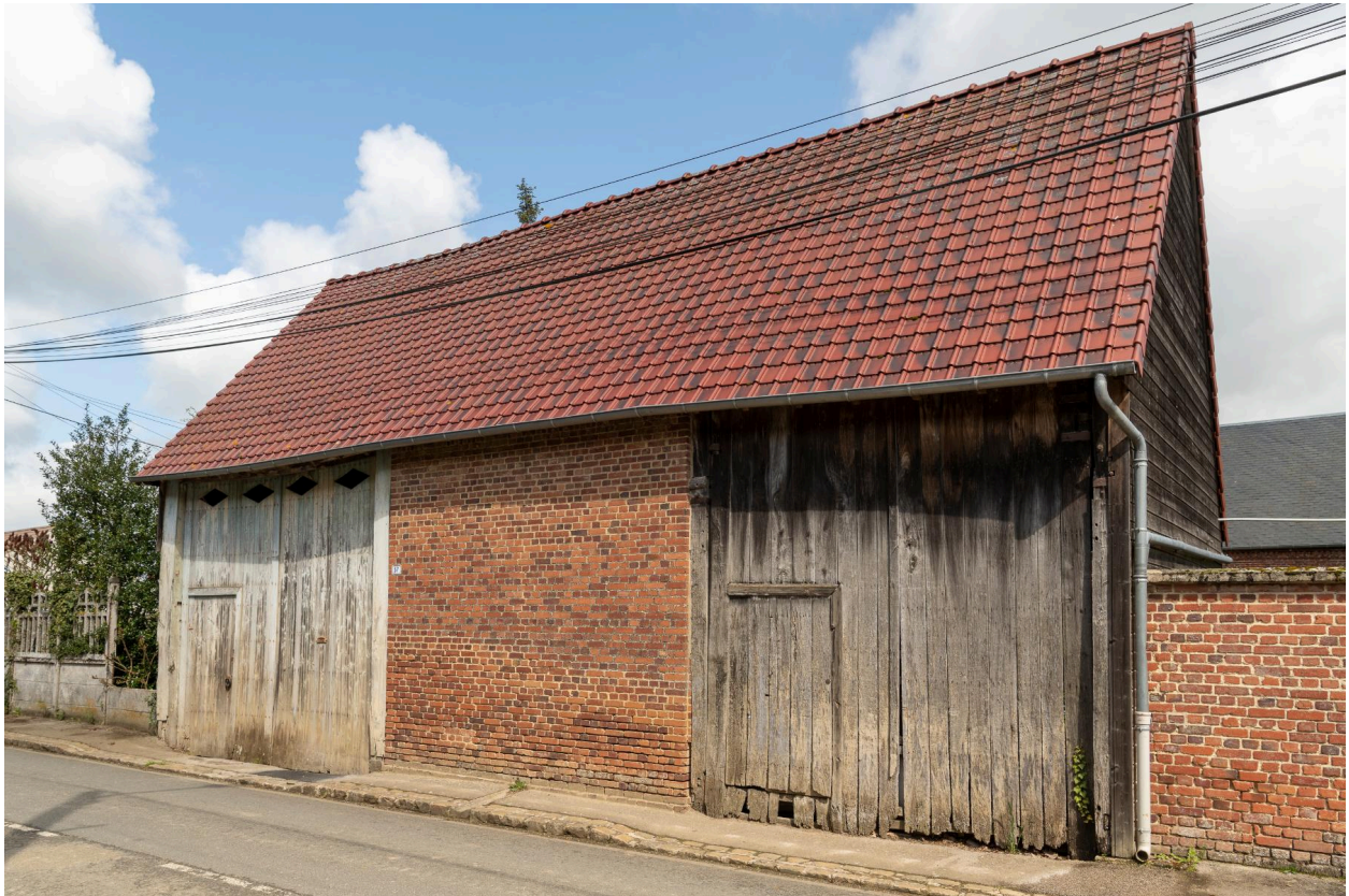
Ancienne grange sur rue, n°57 de la Grande Rue, vue prise depuis le sud.
