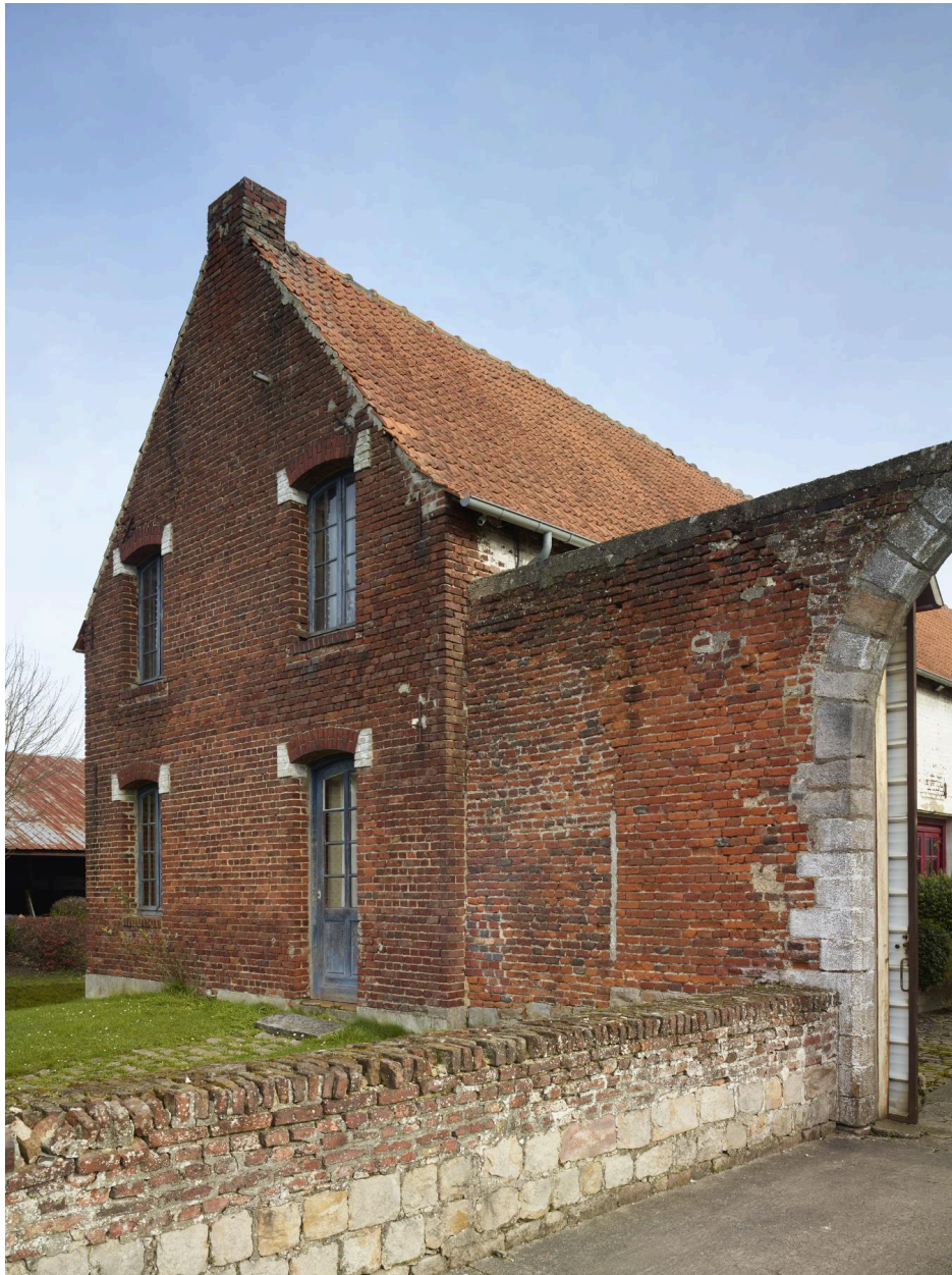
Pignon du logis. Vue prise depuis la rue.
