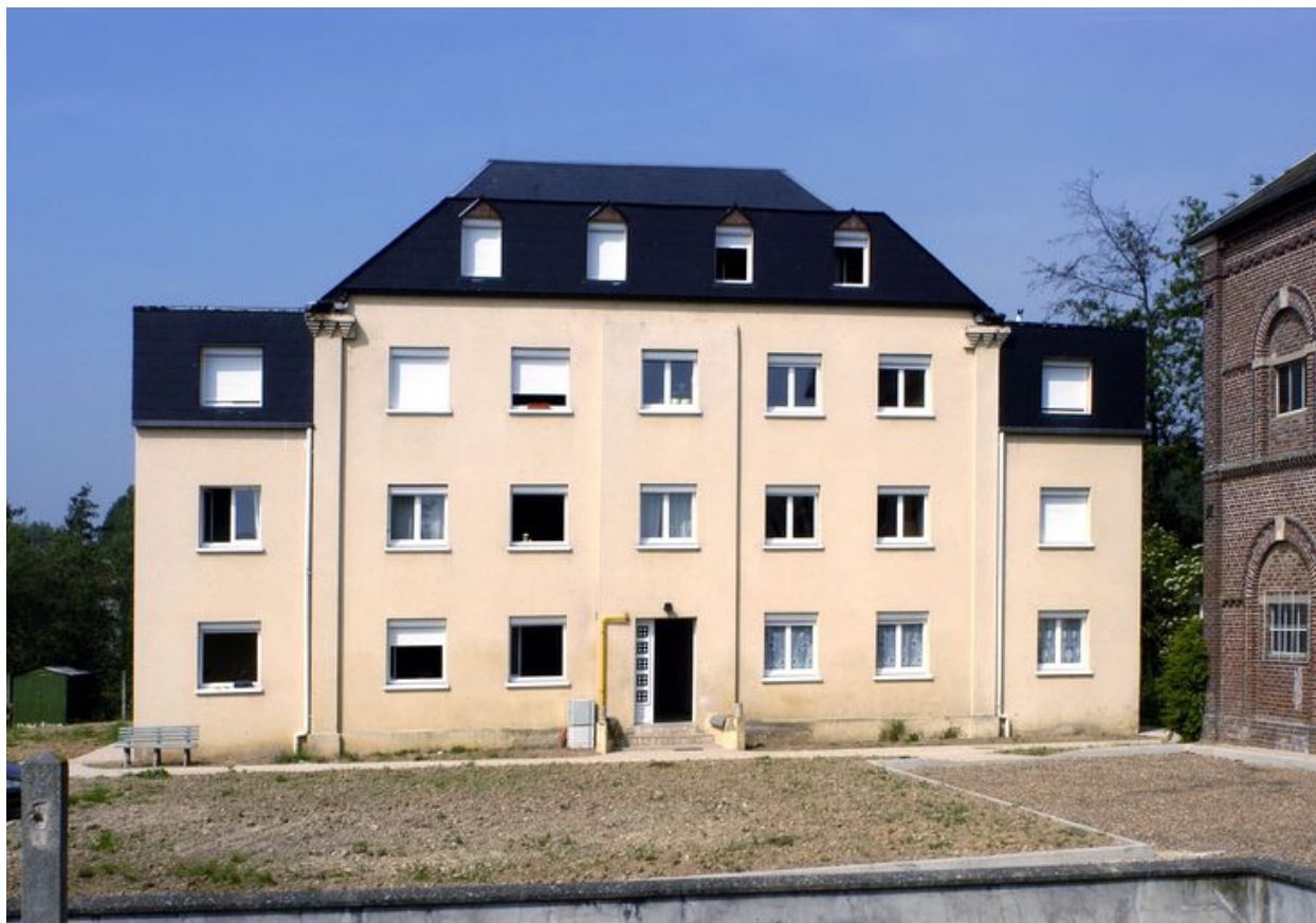
Ancien logement patronal converti en logements, façade sur cour.
