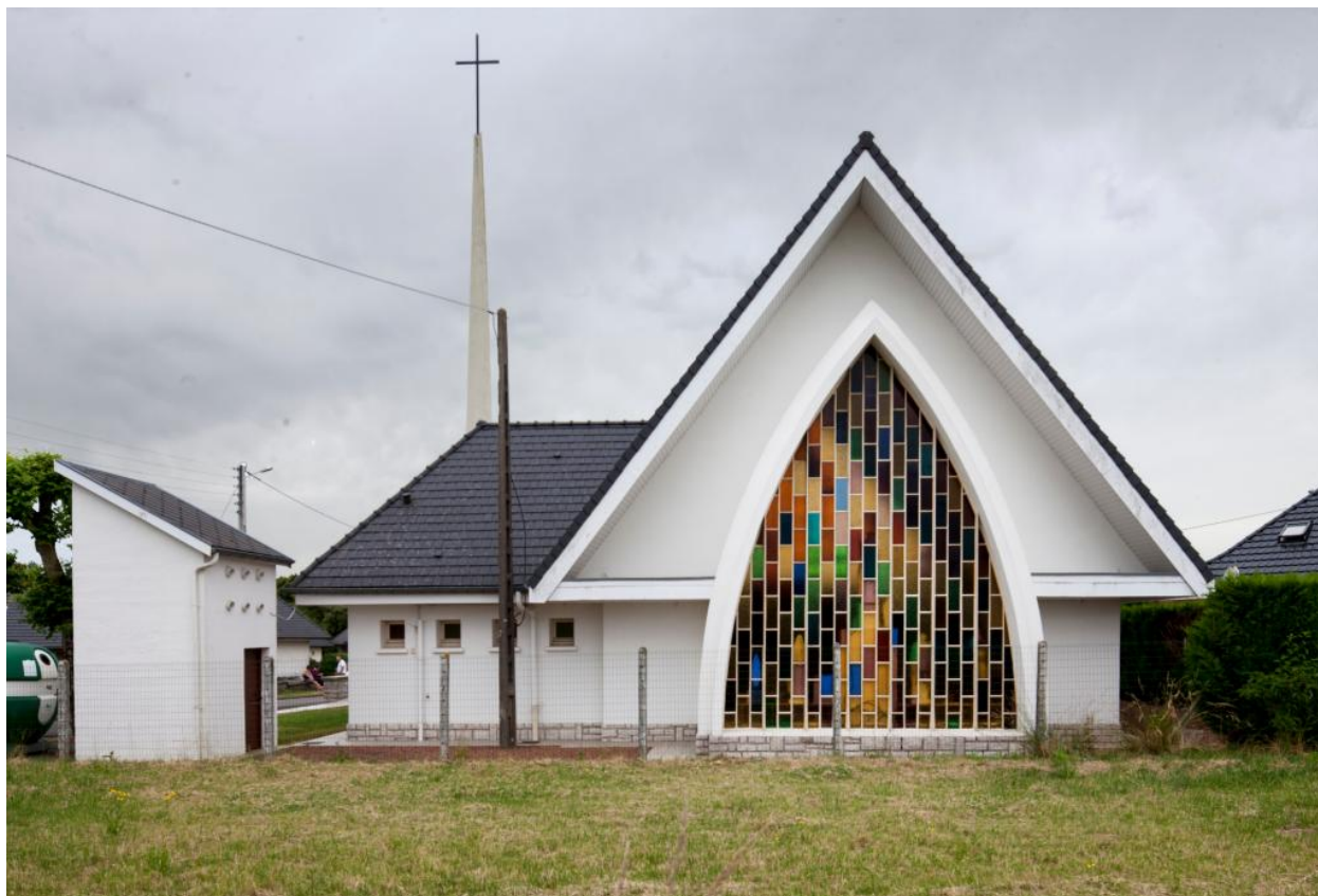
Élévation postérieure, vers l'ouest.
