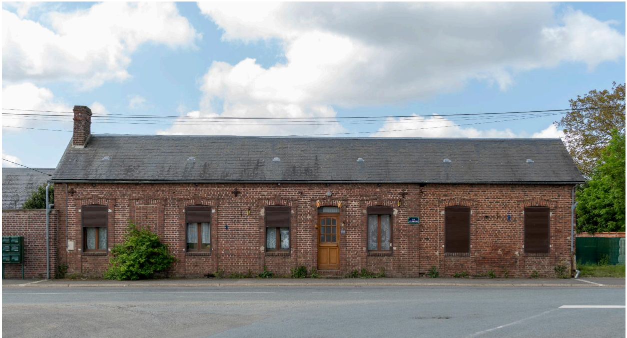
Anciens logements d'ouvriers, n°332 rue des Bouleaux, vue prise depuis le nord.
