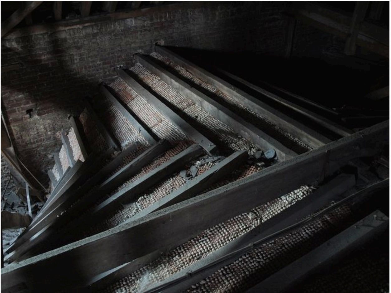
Reins d'une des fausses-voûtes de la nef : lattis bois restauré
