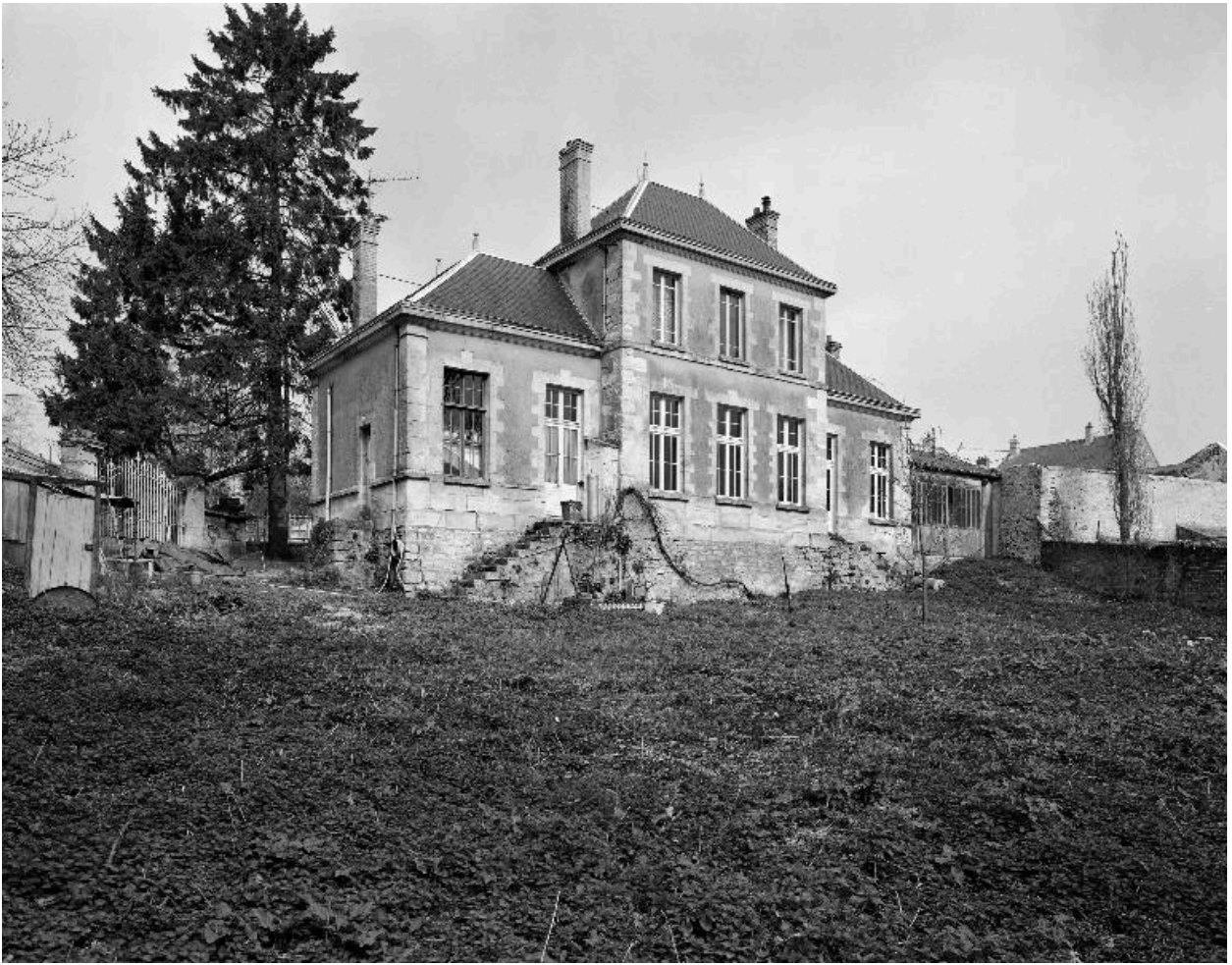
Vue générale de l'élévation arrière.
