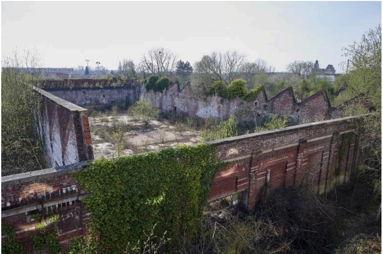
Vestiges sud du tissage. Vue prise vers l'ouest, depuis le couverture du magasin aux fils.
