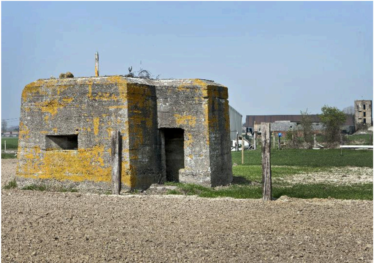
Vue générale vers le nord-ouest
