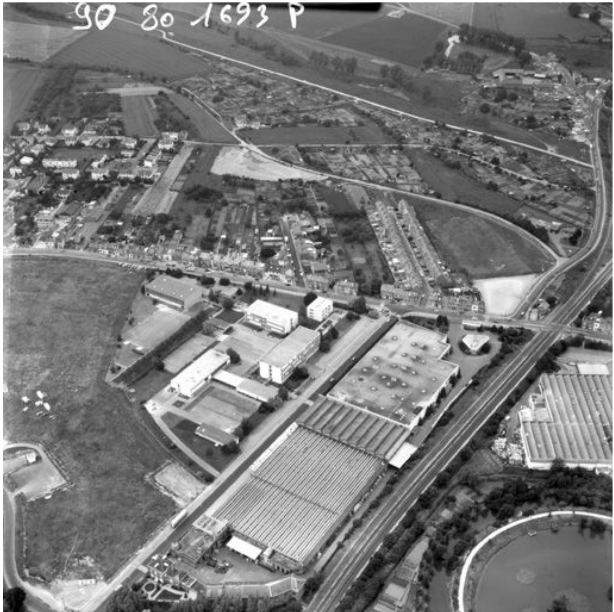
Vue aérienne, flanc sud-est.
