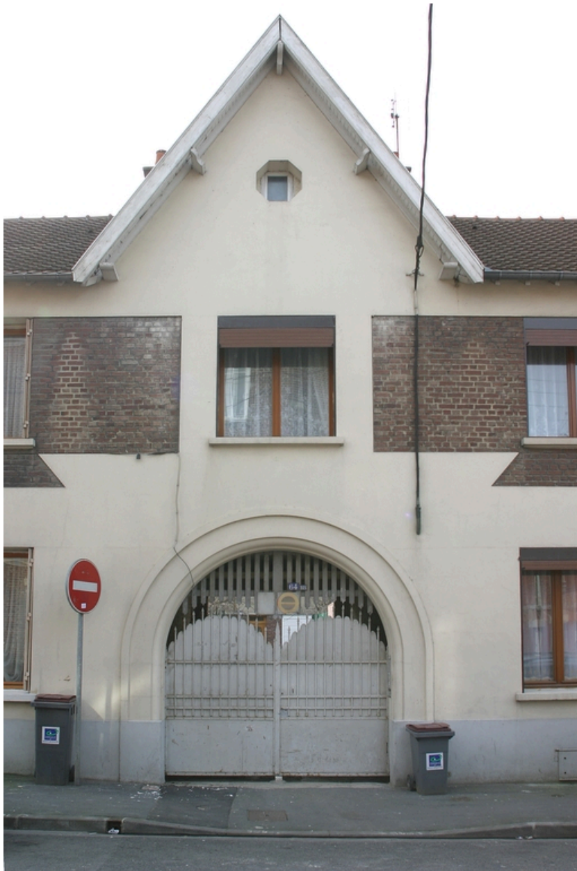
Le portail donnant accès aux logements sur cour.
