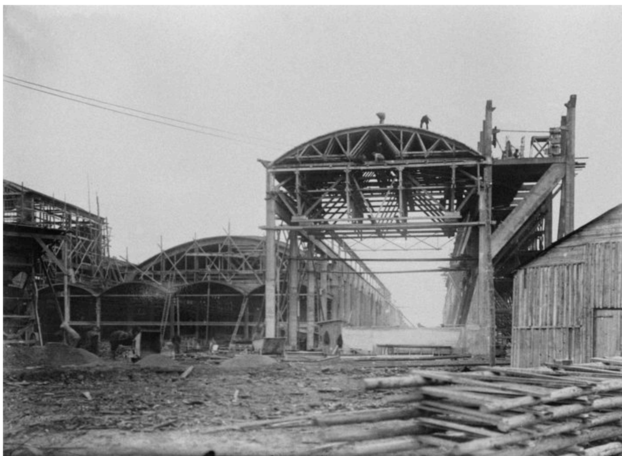
Les ateliers en cours de construction, vers 1923 (AC Thourotte).
