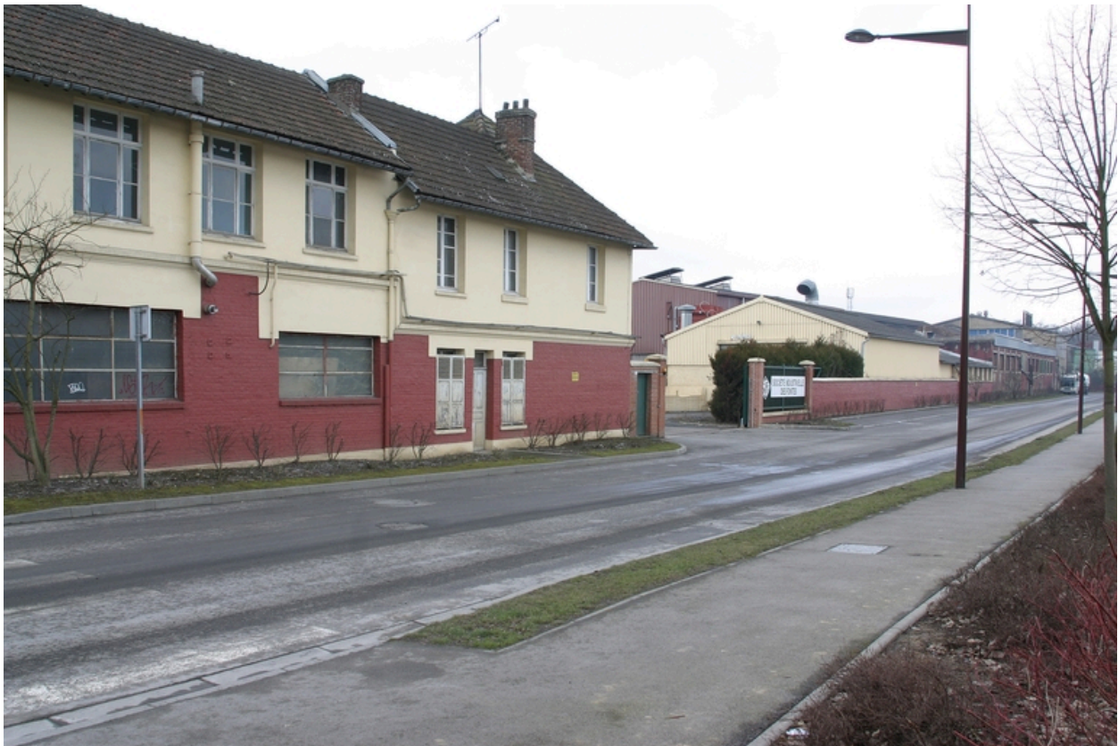
Entrée de l'usine.
