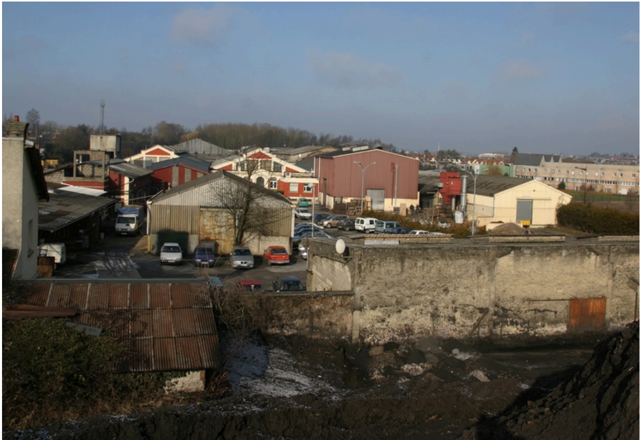
Vue générale de l'usine vue depuis le tas de sable de fonderie usagé.
