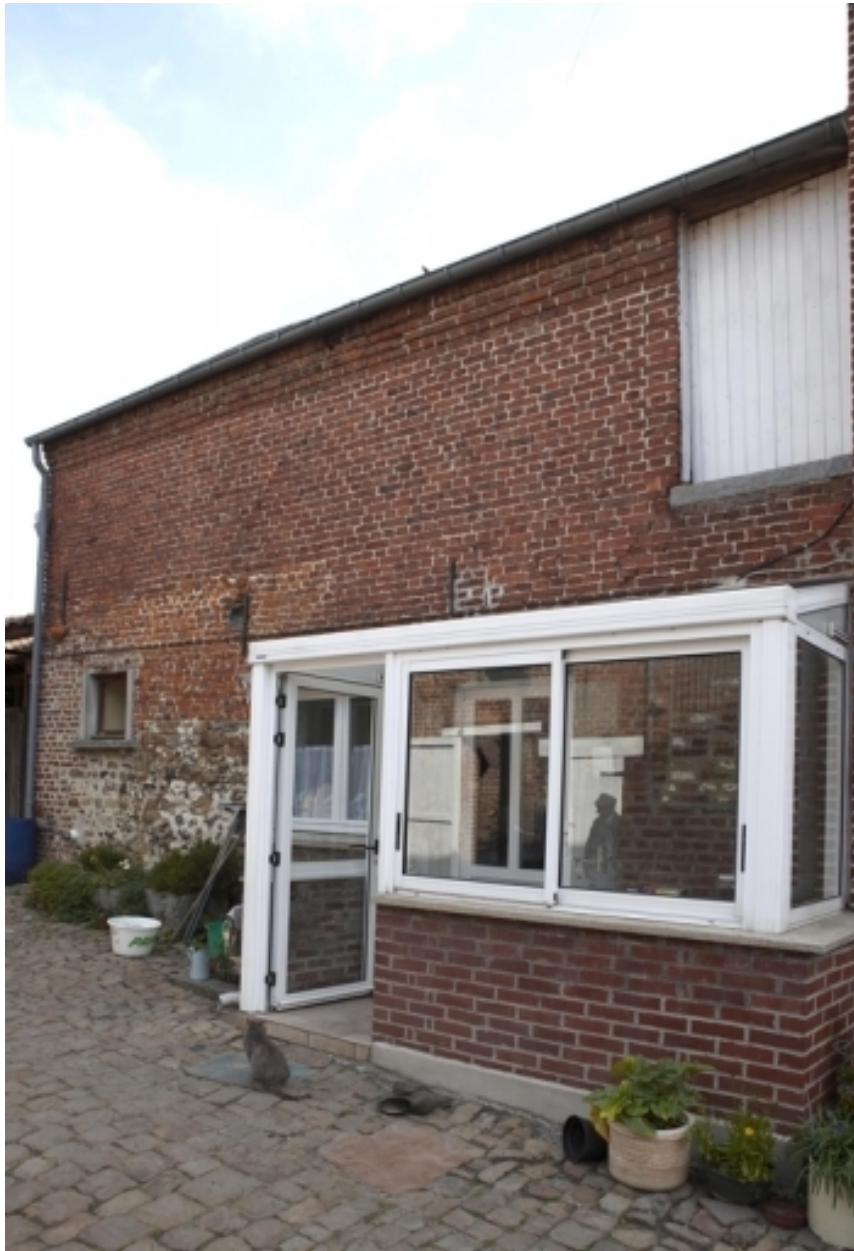
Vue de l'ancienne étable-fenil, transformée en logement.
