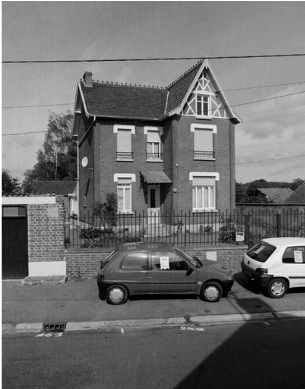
Vue générale depuis la rue de la Résistance.
