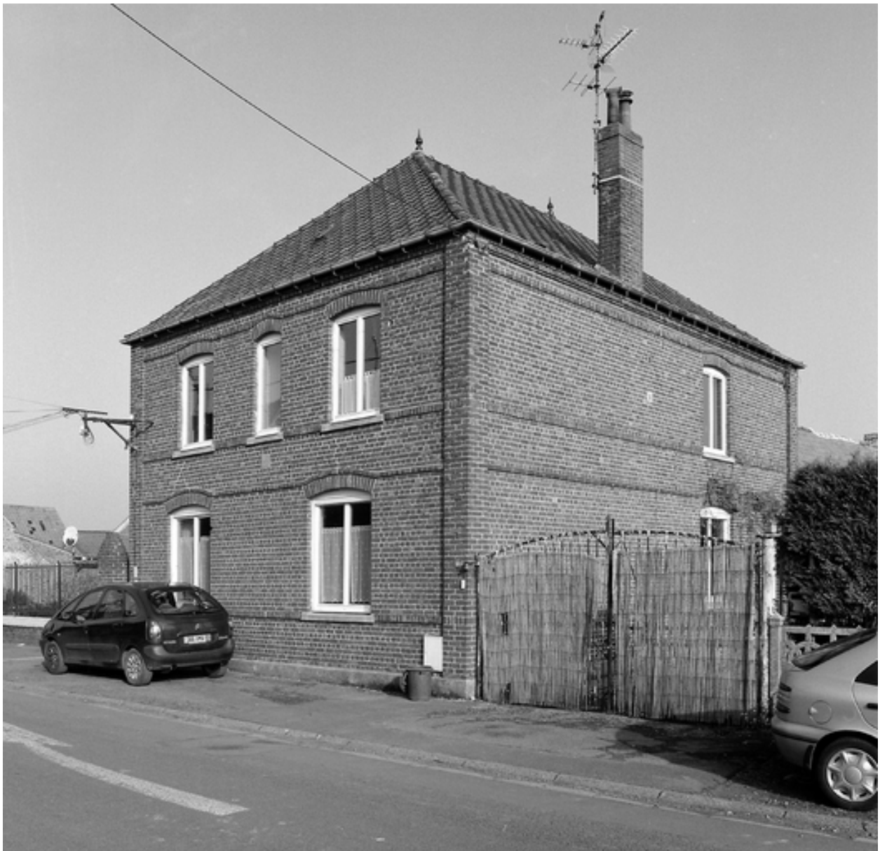
Ferme avec second logis, 101, rue du Presbytère.
