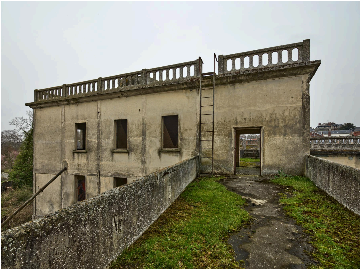
Passage supérieur vers les terrasses de la minoterie.
